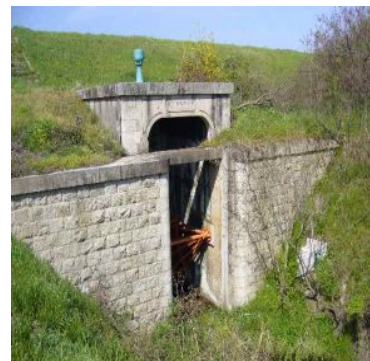
柳井原貯水池配水樋
